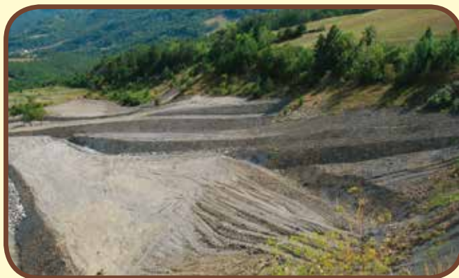
Messa in sicurezza di pendici franose
