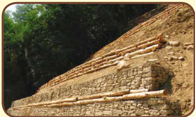
Consolidamento di scarpate
