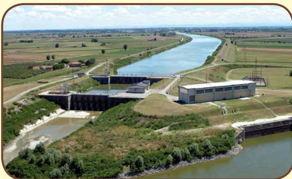
Il Canale Emiliano Romagnolo (CER) , struttura artificiale che porta le acque dal fiume Po, in tutta la pianura fino a Rimini: è questa la fonte principale dell'acqua di superficie impiegata per l'irrigazione dell'agricoltura bolognese
